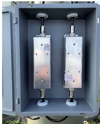
Bild 3: LPF-1 Tiefpassfilter
