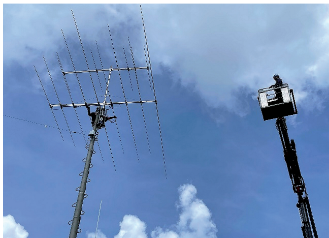
Bild 10: Neuer OptiBeam OB9-5 extra heavy duty
